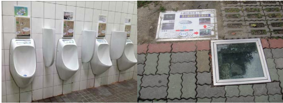
免水小便斗與透水鋪面
